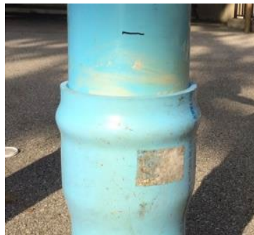
Espita marcada con la raya de la asamblea antes de la inserción
