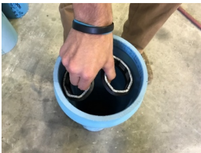
Formación de un lazo para insertar la junta de RieberLok en el surco seco
