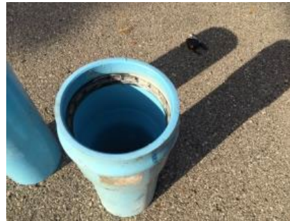
Aplicación del lubricante dentro de la campana
