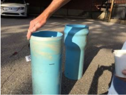
Aplicación del lubricante al extremo biselado de la espita
