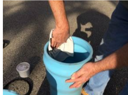
Campana de la limpieza con un trapo limpio
