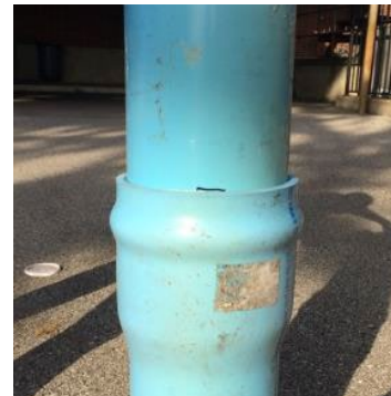
Tubo que sigue la instalación terminada de la junta de RieberLok
