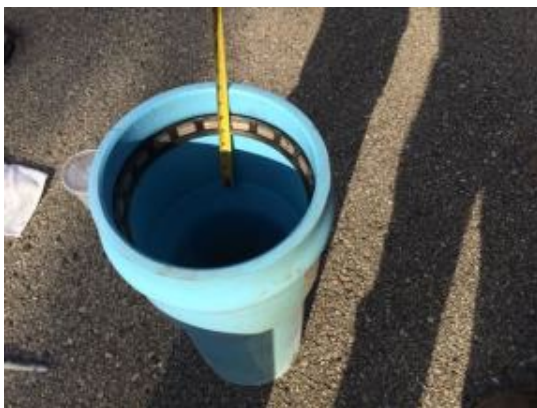
Medición de la distancia del labio de la campana al extremo del zócalo.
